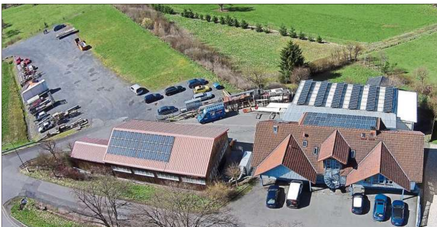
Am Ortseingang von Schwarzenfels ist ein beachtlicher Gebäudekomplex entstanden.
